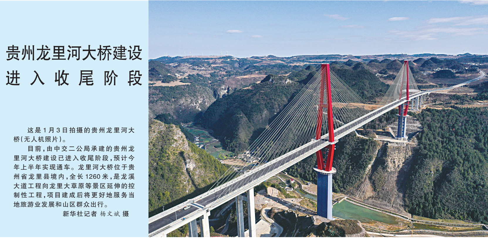
这是1月3日拍摄的贵州龙里河大桥(无人机照片)。
