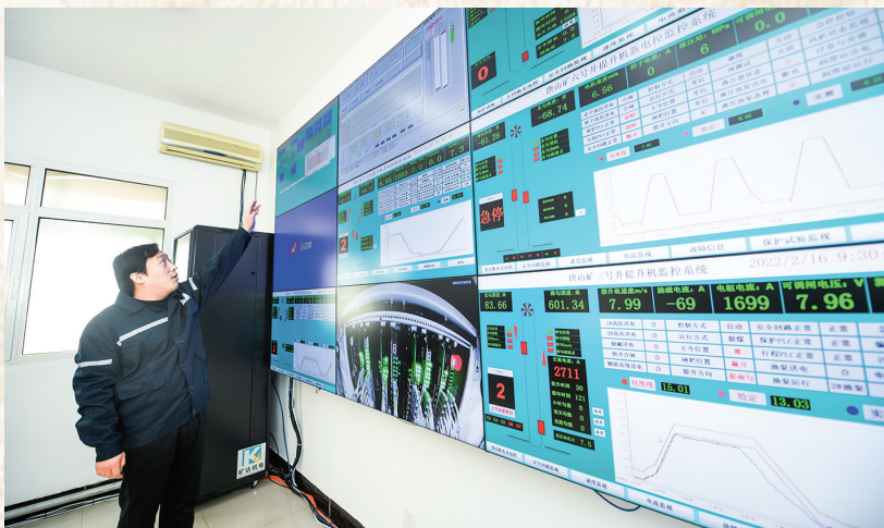
唐山矿提升机电控系统远程监控平台。 唐山矿供图
