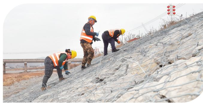
还乡河大松林桥段,工人们正在对两岸的格宾石笼护坡进行检修。
