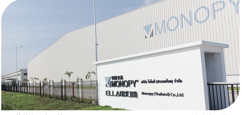
梦牌瓷业泰国精品卫浴项目。
