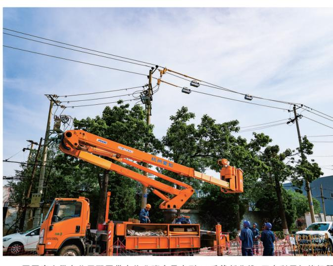
国网唐山供电公司配网带电作业班人员来到10千伏新北线路,正在利用智能机器人对线路进行涂覆作业。 周宇翔 摄
