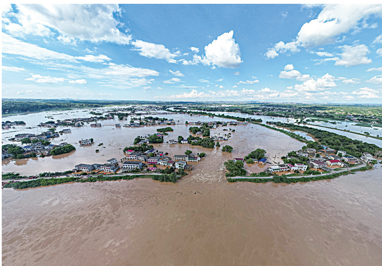
这是7月29日拍摄的涓水湘潭县河口镇华中村堤段决口险情现场(无人机照片)。
