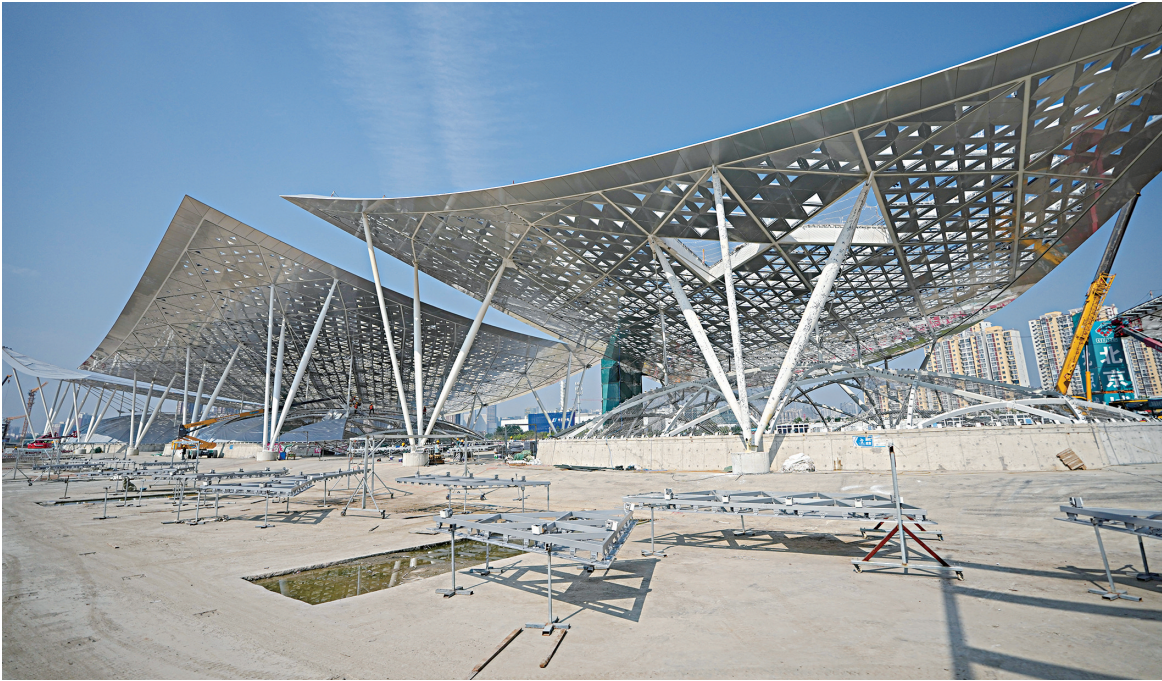
8月30日,施工人员在北京市副中心站枢纽工程现场施工。
