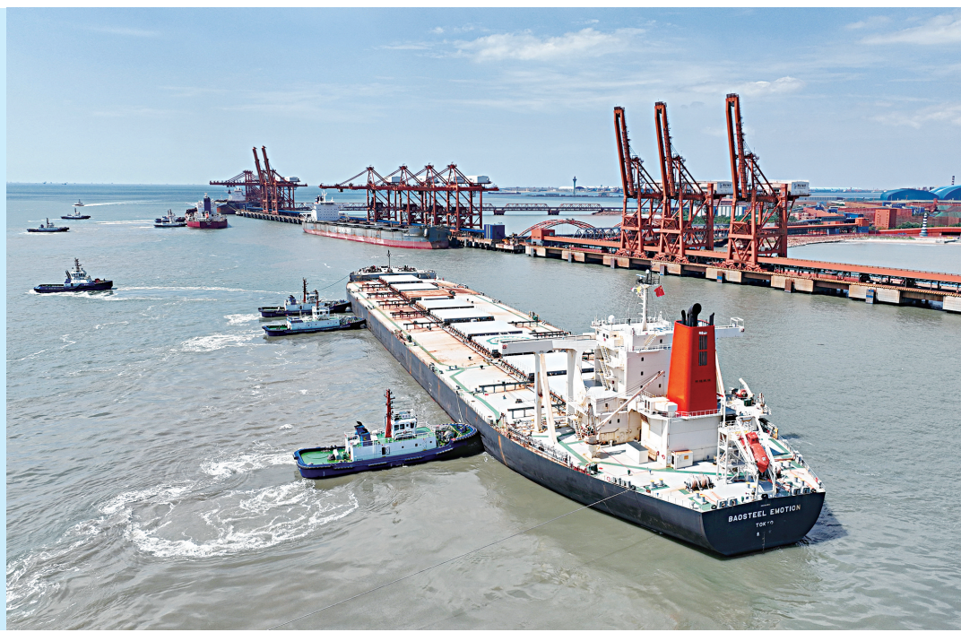
日前，一艘轮船在拖轮的协助下向唐山曹妃甸港区矿石码头靠泊（无人机照片）。
