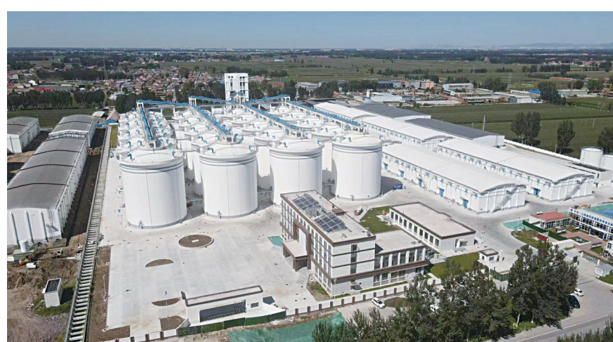
图为中交一公局集团新建国家粮食仓储物流设施项目。
