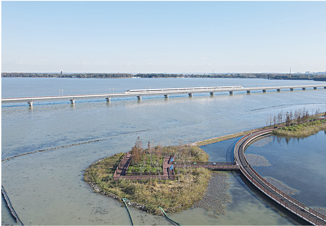
11月23日，列车行驶在沪苏湖高铁青浦特大桥元荡段（无人机照片）。
