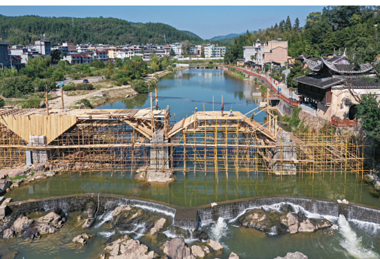
在福建省屏南县长桥镇,工匠在修复万安桥时搭建廊桥桥台拱架(2023年10月18日报,无人机照片)。新华社发(王志凌 摄)
