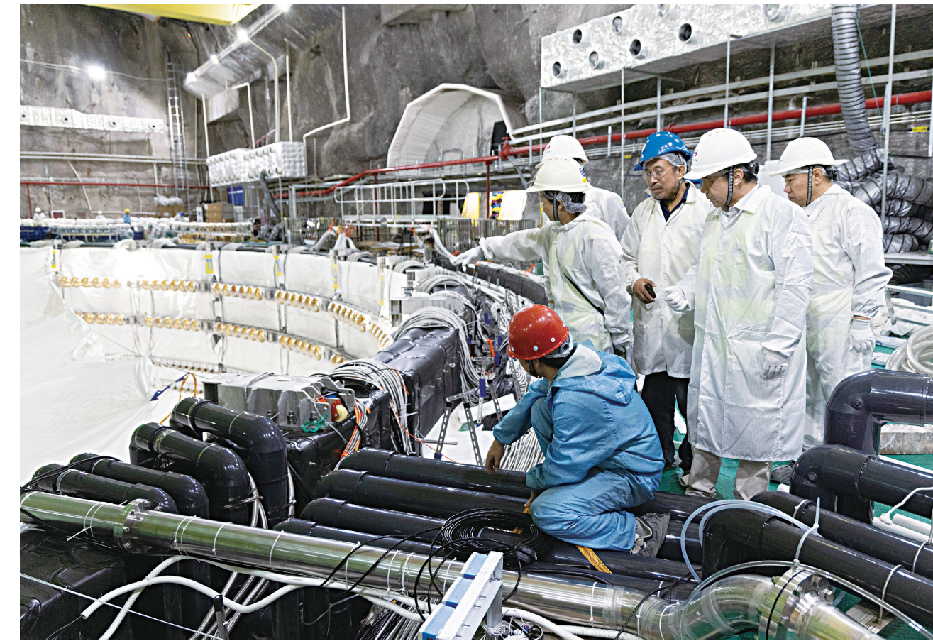
12月18日,江门中微子实验项目经理王贻芳院士(右二)、中国科学院高能物理研究所研究员、江门中微子实验总工程师马晓妍(右四)等在实验大厅检查液体灌注情况。
