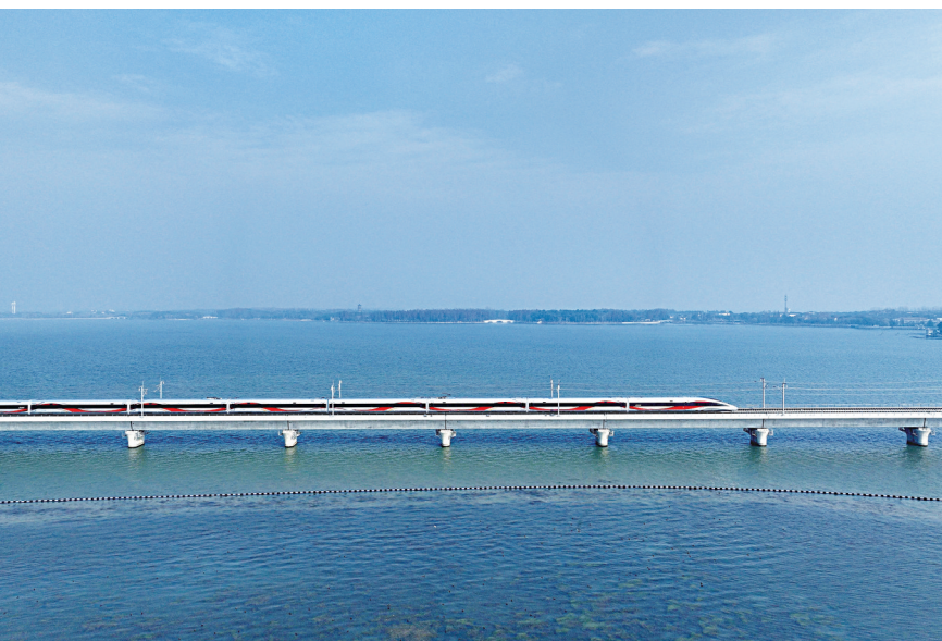
12月26日,列车驶过沪苏湖高铁元荡湖段(无人机照片)。当日,上海经苏州至湖州高铁(沪苏湖高铁)开通运营,上海虹桥至湖州站最快55分钟可达。
