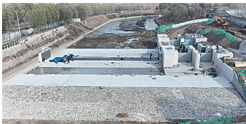
图为陡河河北桥橡胶坝船闸主体结构施工现场。
