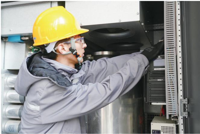
图为测试工程师赵室伟正在检测UPS飞轮储能控制柜电路板。
