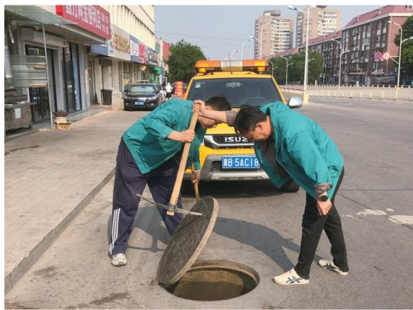
5月份以来,唐山城发集团所属自来水公司对市区市政供水管线设施进行了“拉网式”排查,截至目前排查全面完成,累计检查设施11846座,包括供水井室及井盖9135座、市政消火栓2711座。针对发现的隐患,已全部整改到位,共增补消火栓6座、更换破损井盖预制件19处、修复存在路面安全隐患的井盖4处,实现了设施隐患“动态清零”。下一步,唐山城发集团自来水公司将持续加大设施巡检力度,提升供水保障能力,守护城市供水安全。
