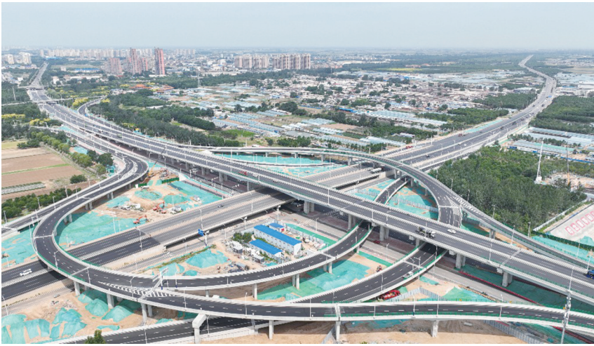
图为6月4日，俯瞰唐通路—二环线立交桥。
