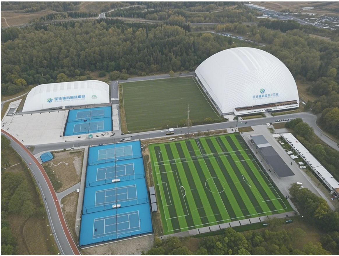
图为唐山花海星球体育中心气膜馆及室外场地。
