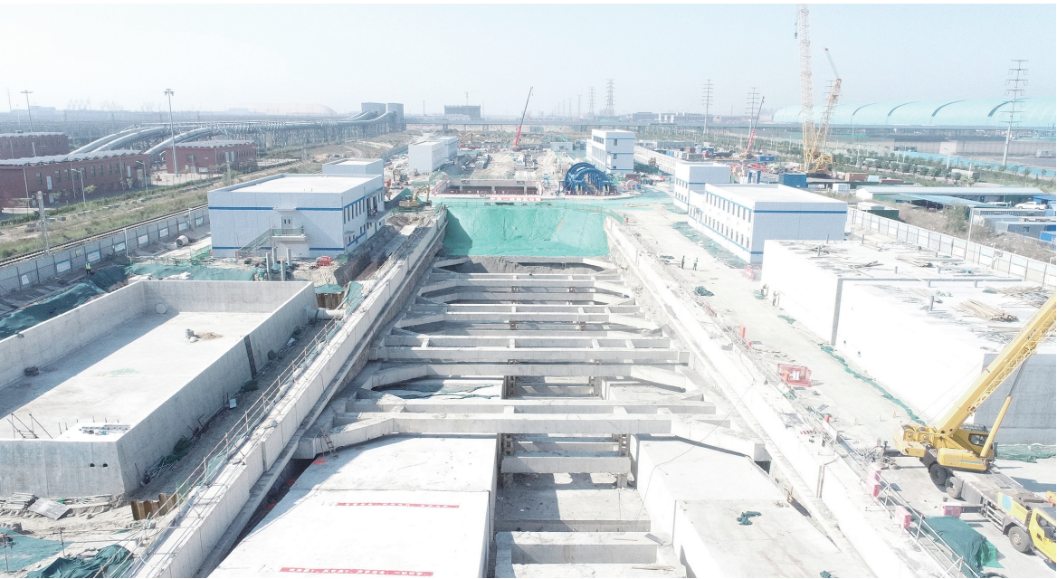
图为唐山港煤炭储运配套翻车机房项目工程现场。
