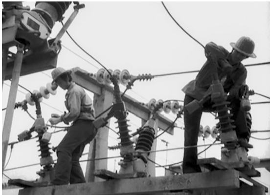
震后,电力职工克服困难迅速恢复电网运行。
