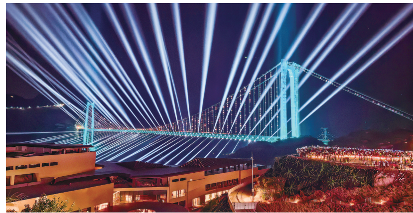
10月11日,游客观赏贵州花江峡谷大桥灯光秀。花江峡谷大桥是贵州六枝至安龙高速公路的控制性工程,大桥全长2890米,主跨1420米,是目前世界山区峡谷第一大跨度钢桁梁悬索桥;其桥面距水面垂直高度625米,超越北盘江一桥成为新的世界第一高桥,被誉为“横竖都是第一”。新华社记者 杨文斌 摄
