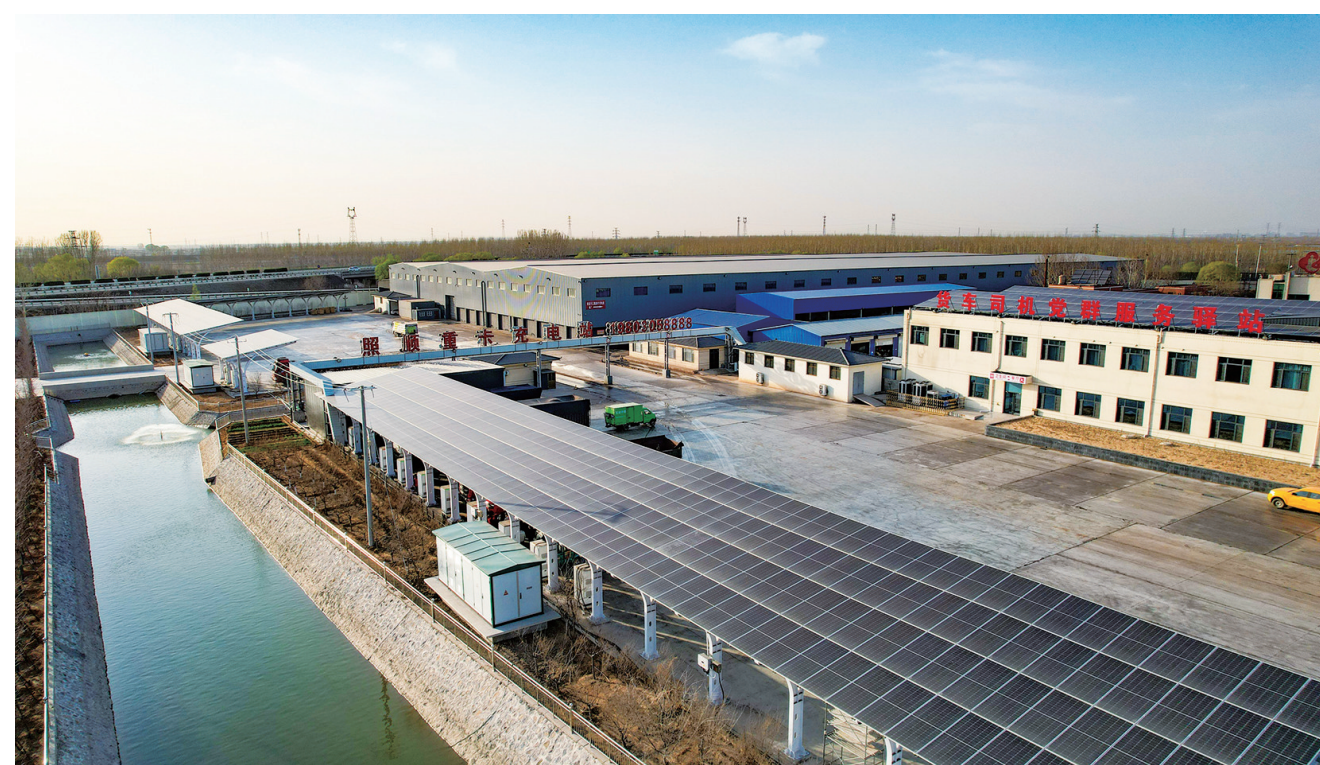
图为位于唐山市丰南区黄各庄镇唐曹高速口的照顺环保科技有限公司“光储充”一体充电站。
