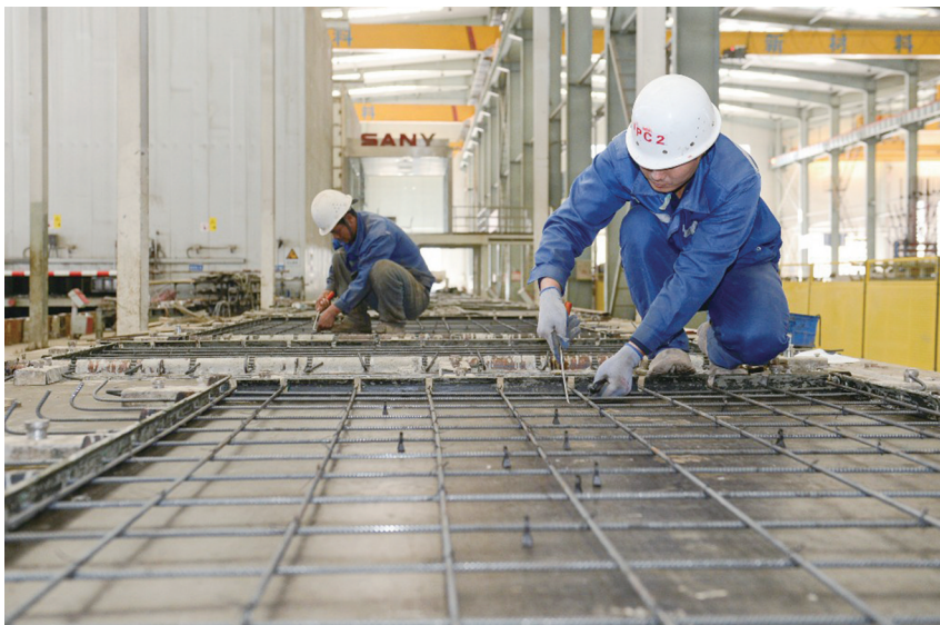
图为津西钢铁叠合板产线上工人正在绑扎工位进行作业。 杜雯拓 摄
