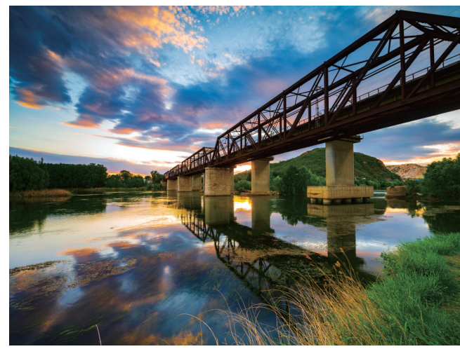
■中国第一座大型铁路桥——滦河大铁桥
