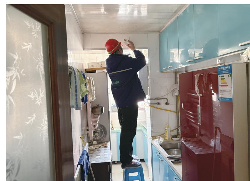
2025年唐山市燃气集团工作人员在都市花园小区安装报警器（资料片）。市住建局供图
