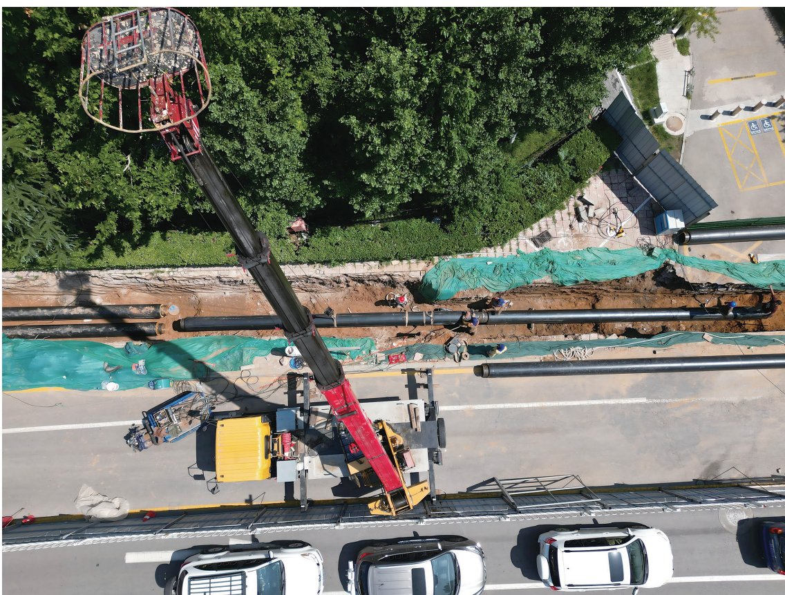
图为凤道支干线改造工程现场（资料片）。
