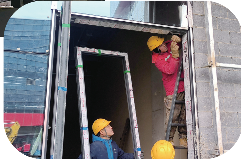
图为建设现场。马雅雄摄
