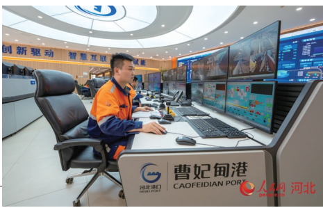
▲曹妃甸港矿石码头操控室。
