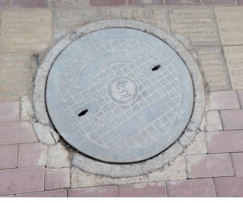
图为更换后的井盖。钱琨摄
