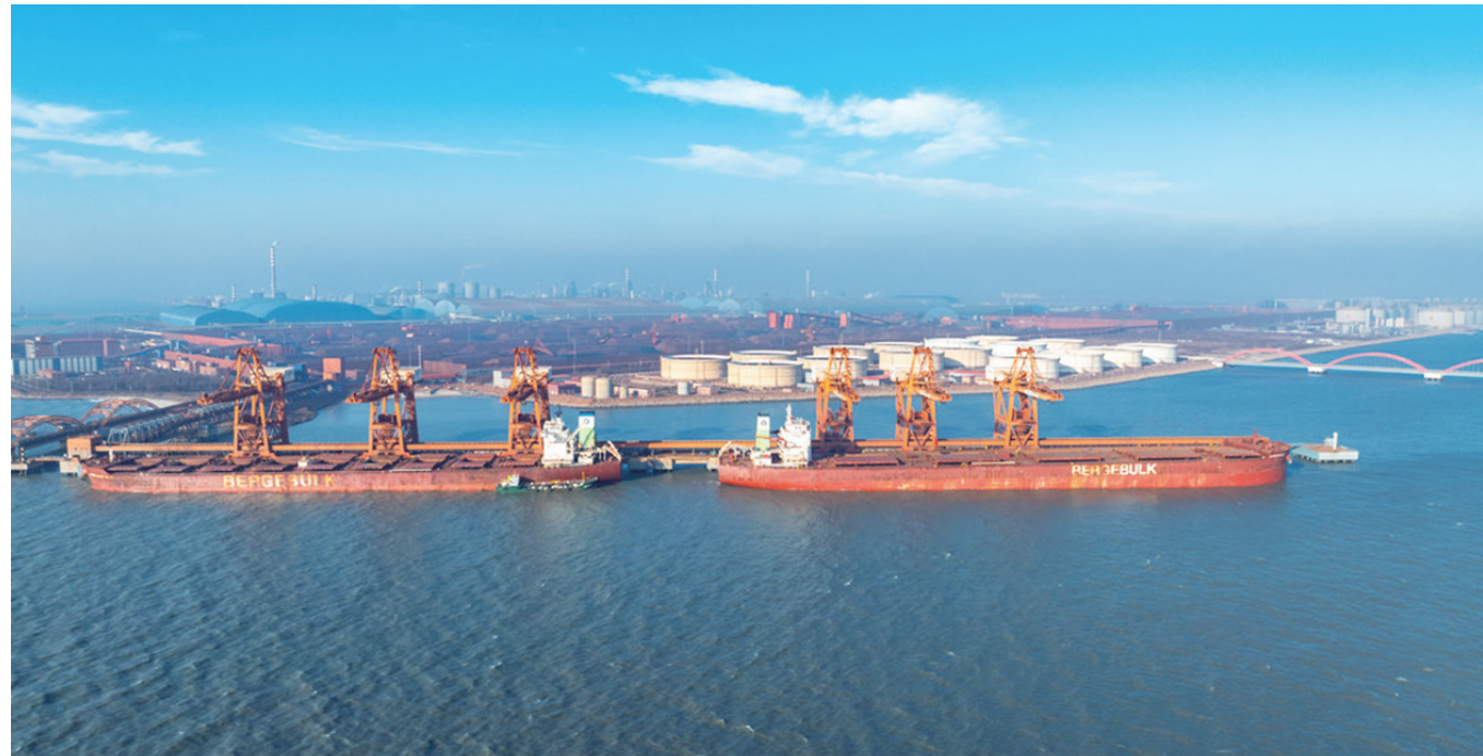
近日，在唐山曹妃甸港区矿石码头，货船在装卸作业。
