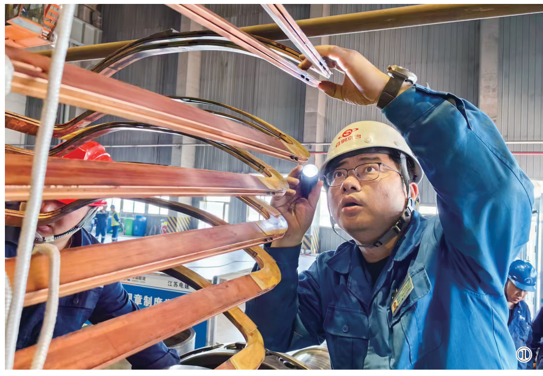
图①“五一”假期,首钢京唐公司各生产现场仍是一片繁忙景象,在能源与环境部热电作业区1号300兆瓦发电机组检修现场,电气自动化工程师邢智鑫正对发电机定子线圈进行专项检查。
