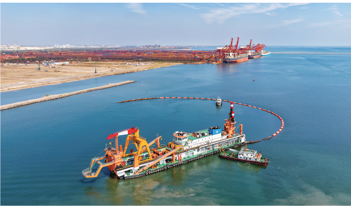
图为大型绞吸式挖泥船“天麟号”正进行疏浚作业。
